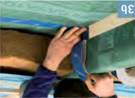
3b Neprodýšné slepení přesahu pásoviny se systémem pomocí lepicí pásky TESCON No. 1 nebo TESCON VANA. Pásku je třeba lepit středem na spoj a pomocí pro clima PRESSFIX pevně přitlačit.
