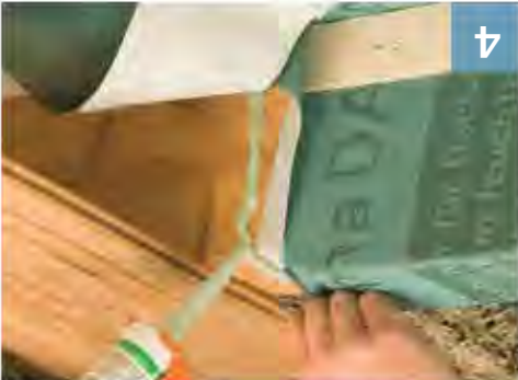
4 Pro napojení na drsné nebo minerální stavební díly naplocho, aby se dokázalo absorbovat pohyb F nebo ORCON CLASSIC. Lepidlo se nestlačí zcela se nanese cca 5 mm široký proužek lepidla ORCON pomocí neprodýšných manžet a v případě potřeby rohově lepicí pásky TESCON PROFIL.
