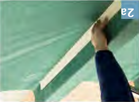
Pásovina se instaluje horizontálně (příčně ke krokvim /stropním trámům). Začíná se na zdvihajícím se vnějším zdívu. Pásovina se položí celoplošně na strany krokvi a podklad a pečlivě se přitlačí do rohu. Je třeba se zabránit vytvoření konvekčního tunelu.
