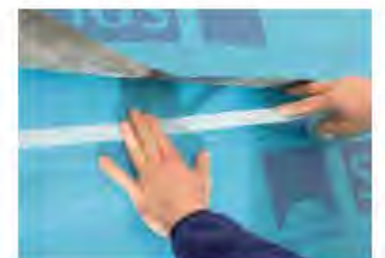
TESCON VANA K lepení přesahů pásovinu
