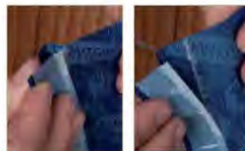
Dřevorámová konstrukce CONTEGA IQ již byla ze strany nalepena na rám, například firmou instalující okna.
