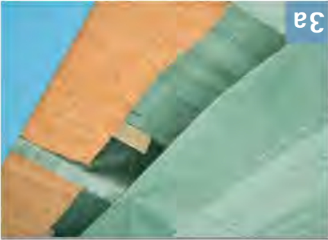
3a Rozviněte další část. Přesahy pásoviny mají být cca 10 cm. Natištěné označení slouží pro orientaci.
