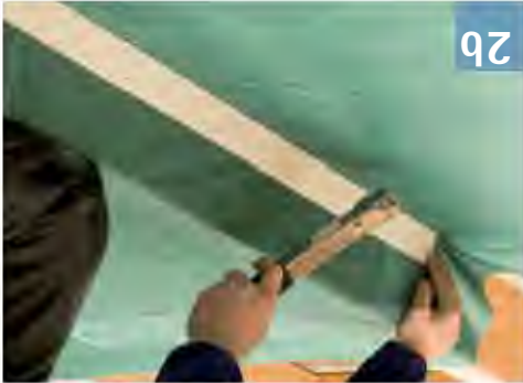
Pásovinu upevněte na stranách krokvi pomocí cca 3 mm silné překližky nebo pásky z dřevovláknitých desek při spodní hraně boku kroky. Upevňovací pásky je nutno používat průběžně. Jednoduchá fixace je možná například ruční nastřelovačkou spon.
