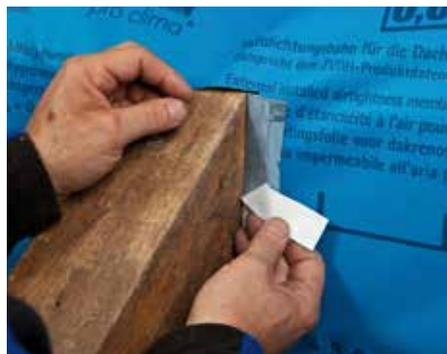
Trennfolie ablösen: Bahn und Sparren luftdicht verkleben.
