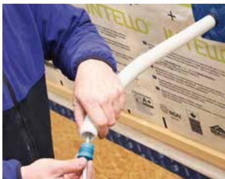
STOPPA dichtet Kabel in Leerrohren ab.
