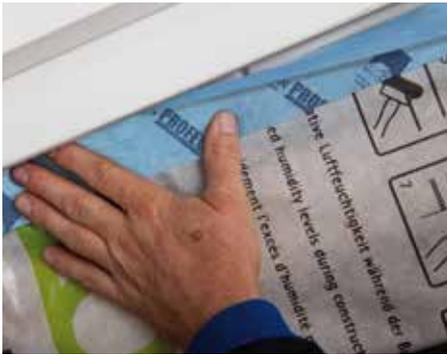
Anschlüsse an Einbauteile innen,
