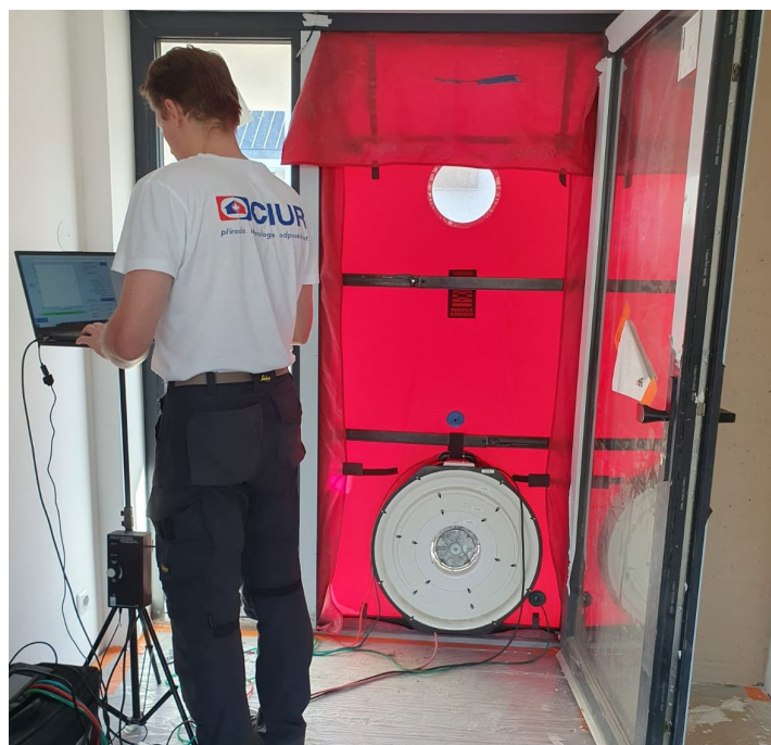
Měření blower-door testu v praxi
