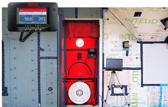
Metodické měření blower-door testem. Ucpávka dveří.
